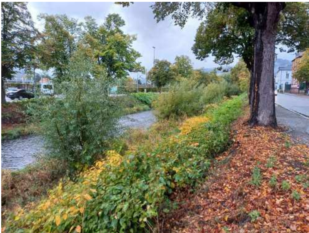
Figure 4 : Vue en amont de la passerelle
