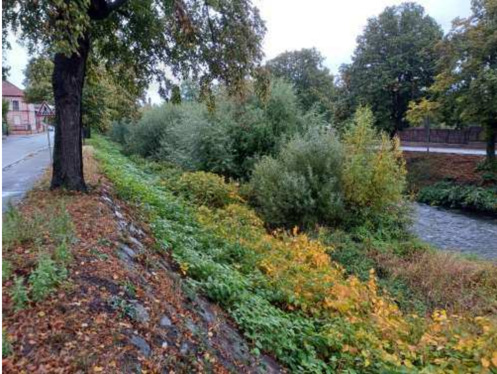
Figure 3 : Vue en aval du pont Staub
