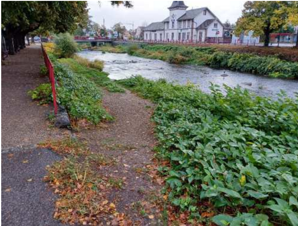
Figure 5 : Vue de la rampe d'accès en aval
